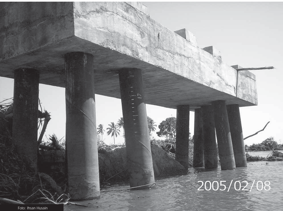
Kondisi pelabuhan laut paska tsunami tidak berfungsi
