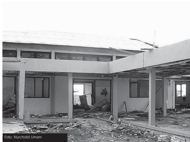
Bangunan permanen yang hancur karena musibah tsunami
